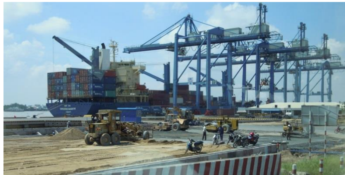
ガントリークレーン
